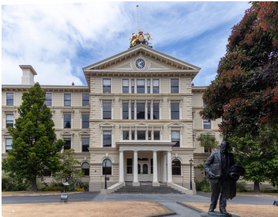
Das alte Regierungsgebäude gilt als eine der grössten Holzbauten in der Welt
